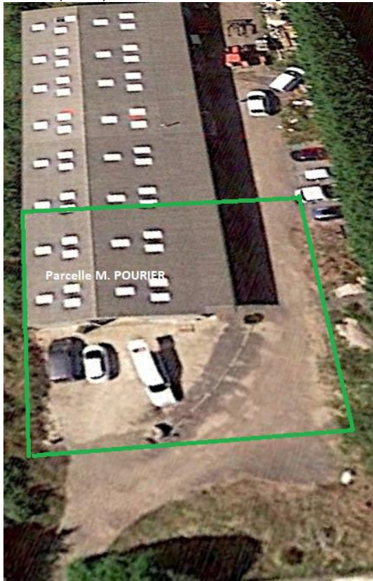
Parcelle préemptée de M. POURIER- Google Earth
